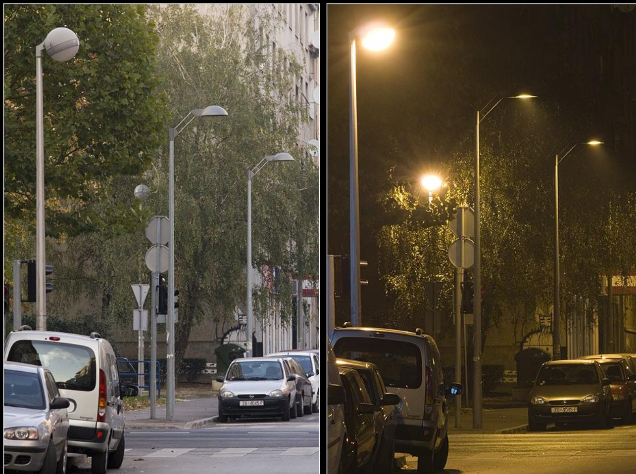
USPOREDNI PRIMJER NEEKOLOŠKE I EKOLOŠKE RASVJETE –GRAHOROVA ULICA , ZAGREB
